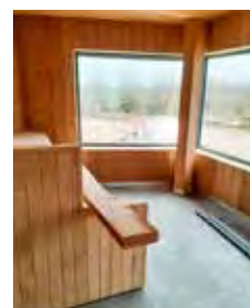
Travaux d'aménagement de l'espace bien-être
