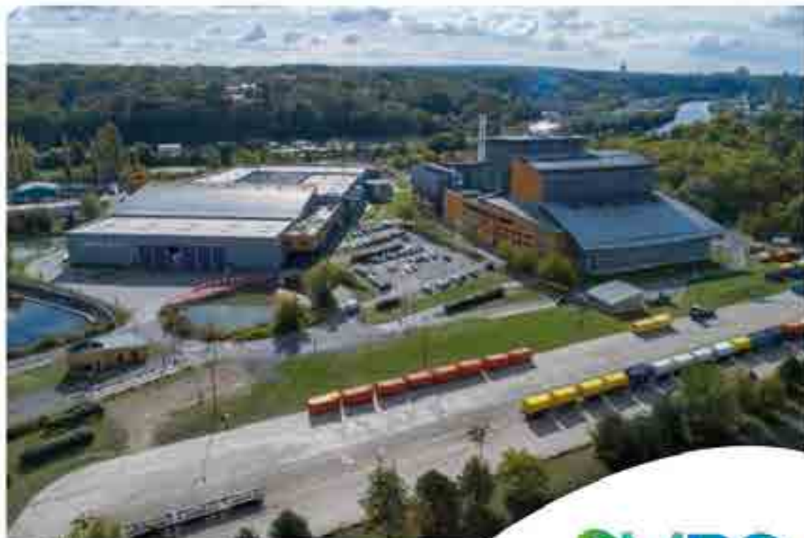
Site de traitement des déchets de la Communauté de Communes du Vexin-Thelle
